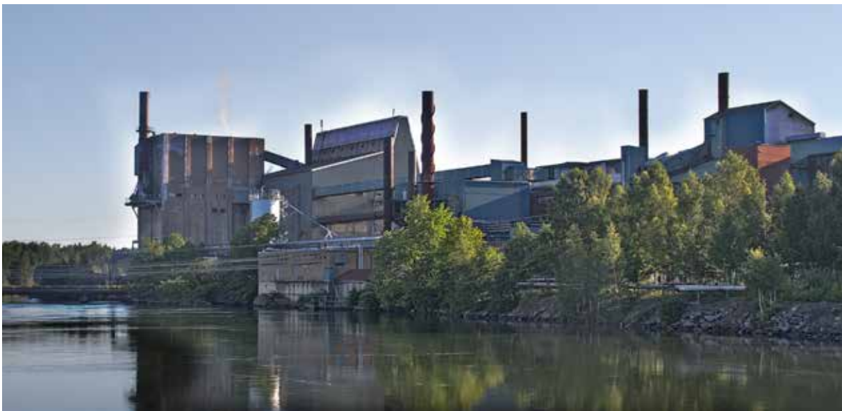
Smältverket i Vargön 1974. Då fanns ett flertal öppna ugnar som saknade rening. Några år senare byttes dessa ut mot slutna ugnar försedda med ångpannor samt slangfilter med 99,9 procents reningskapacitet.
